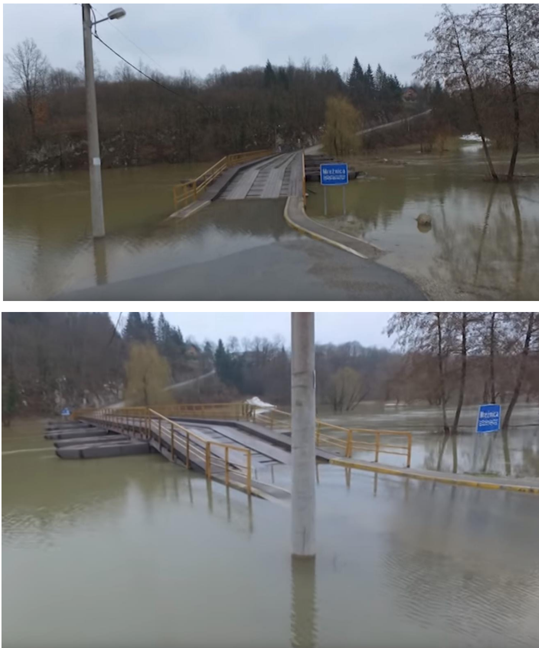
Slika 3.18 Plavljenje pristupne ceste postojećeg pontonskog mosta u ožujku 2018. godine uslijed izljevanja rijeke Mrežnice iz korita (Izvor: YouTube)
